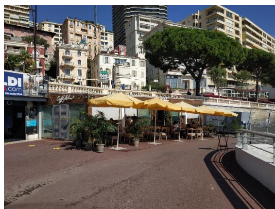
Terrasse Caffé Milano à démonter
